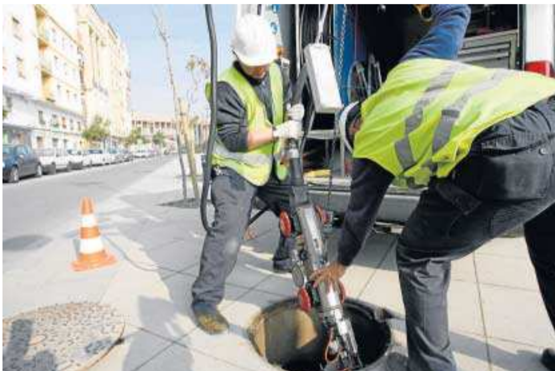
Dos operarios instalan una red de fibra óptica en Córdoba.
