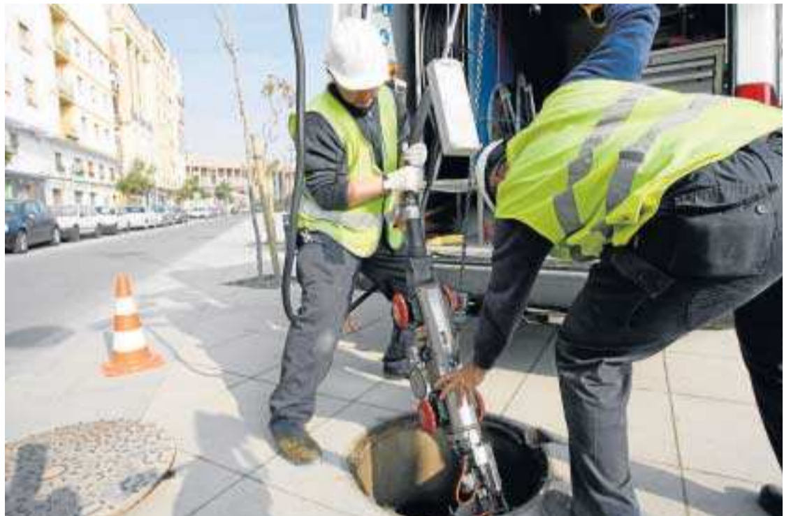
Dos operarios instalan una red de fibra óptica en Córdoba.
